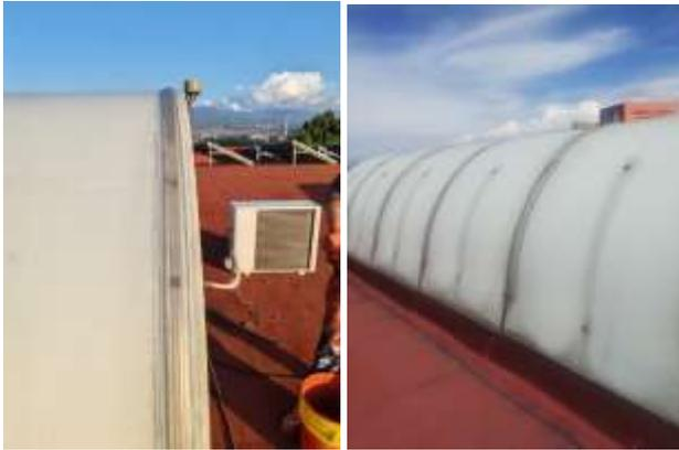
**Impermeabilización en el edificio de rectoría:** Colocación de membrana en los muros para evitar la filtración de agua.
